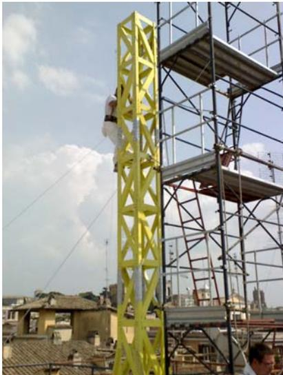
I profili per impiego strutturale, a somiglianza di quelli metallici, sono costituiti da profilati piatti, con sezione ad L, ad U, a T, ad I e ad I con ali larghe (wide flange), tubolare, eccetera. Nel caso in cui la struttura sia stata progettata per un prefissato tempo di esposizione al fuoco, le combinazioni di azioni da adottare corrispondono a quelle indicate come eccezionali nella normativa vigente.
